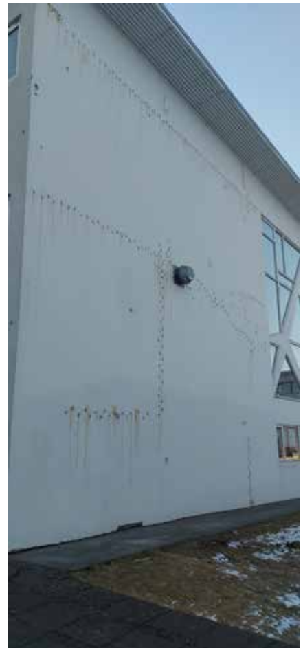
Mynd 2: Sprunguviðgerðir með inndælingu vegna kuldabrya við samskeyti milliþötu og innvegg í íslenskum útvegg.
