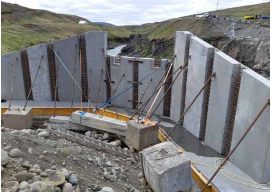
Mynd 1: Samsetning forsteypts brúarstöpsuls í nýlegri brú yfir Jökulsá á Dal við Hákonarstaði.
