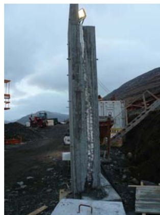
Staðsteyptur samlökuveggur prufa
