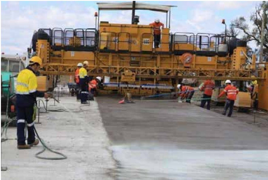
Niðurlagning á 70.000 tonnum af EFC ( earth friendly concrete ), geopolymer steinsteypu, á West Wellcamp flugvellið í Brisbane Ástralíu.
