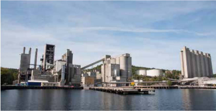
Föngunarstöð Norcem í Brevik (CCS) sem tekur til starfa í júní 2024, fangar 55 tonn CO 2 á klst og dregur úr heildarútbæstri um 400þús tonn CO 2 á ári.
