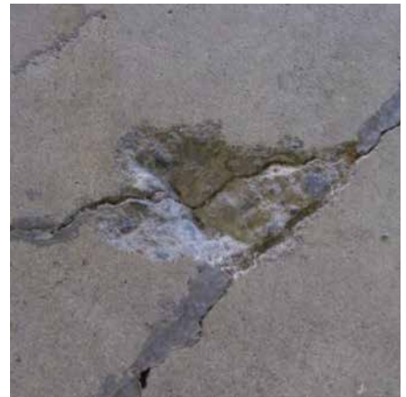
Mynd 2: Frostskepping í steypu af völdum staks malarkorns með háu mettvatnsinnihaldi
