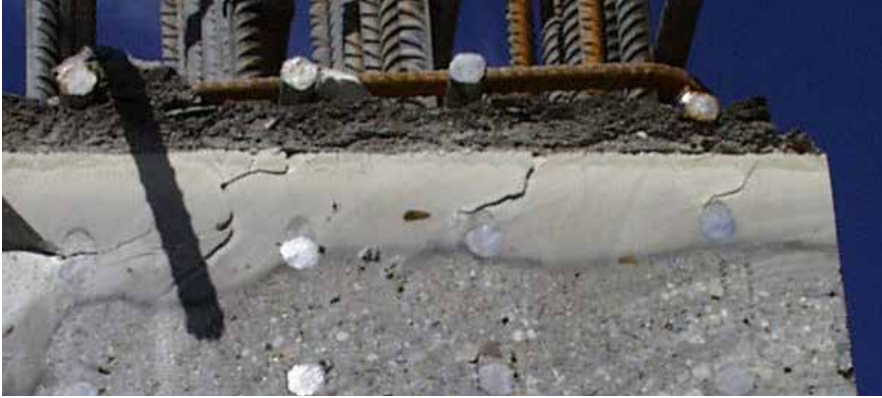
Mynd 1: Dæmi um aðskilnað í steypu
