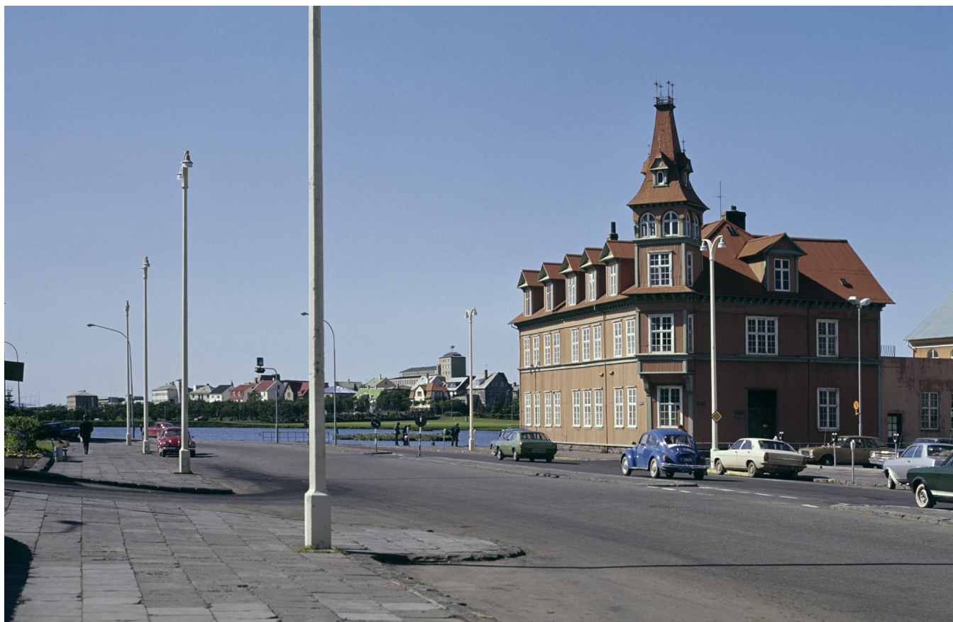
Steyptir ljósastaurar í Lækjargötu 27. september 1975.
