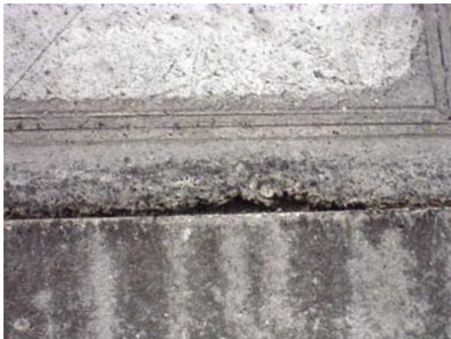
Myndin sýnir léleg steypuskil. Myndir þú láta gera við þetta?
