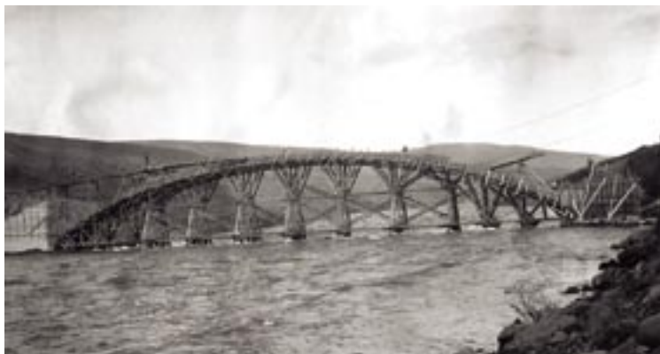
Steypuvinna. Lengst til vinstri er maður með hjólbörur að keyra eftir trillubraut sem var aðeins um 35 cm breið. Engin handrið voru til öryggis.
