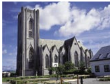
Landakotskirkja, 1925 - 29. Arkitekt Guðjón Samúelsson. Eina steinsteypa gotneska kirkjan í heiminum
